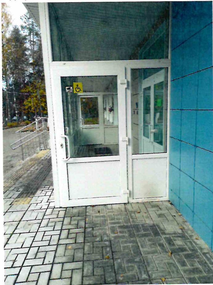
Фото № 5 Дверь вход/выход
